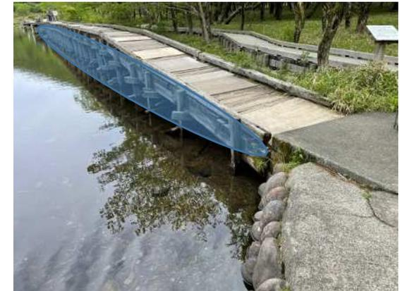
▲木道の損傷状況。青枠で示している受木(大引)が複数破断しております。
